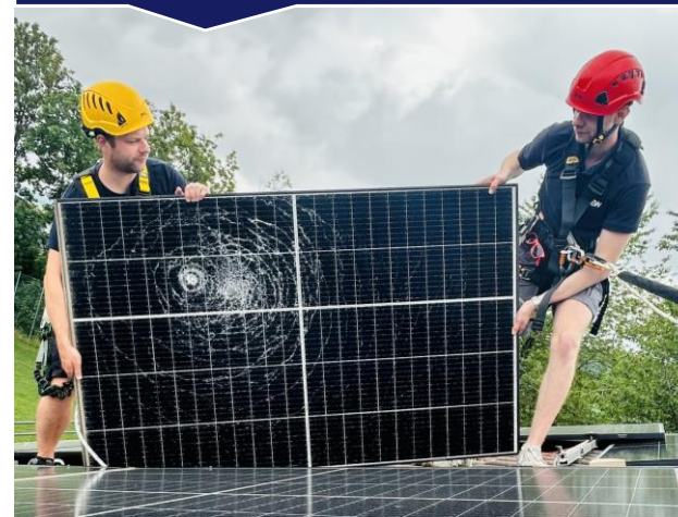
Reparatur nach Schadensfall
